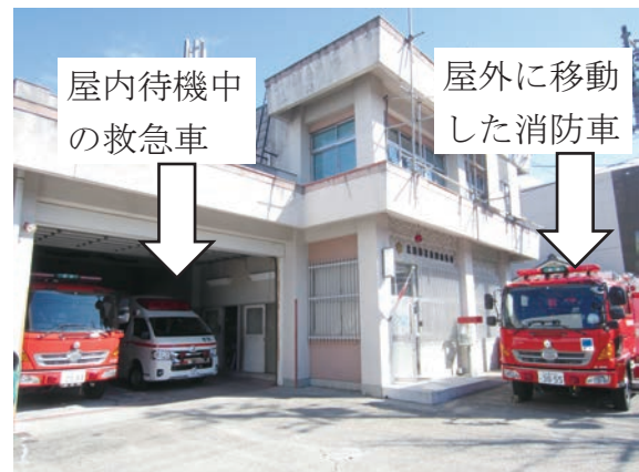
救急車は車室内の温度上昇を抑えるため屋内で待機させるのが原則だが、移動先の出張所には屋内の駐車スペースが空いていないため、消防車を屋外の駐車場に移動。
